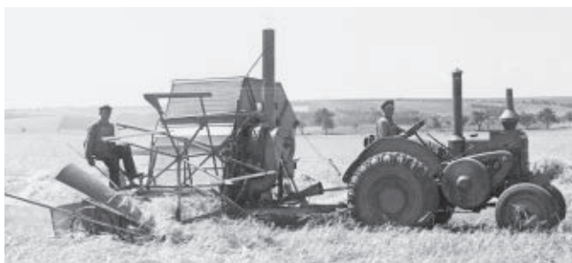
Der gezogene Mäh-Dresch-Binder (MDB) war 1936 der erste voll funktionsfähige Mähdrescher Europas.
