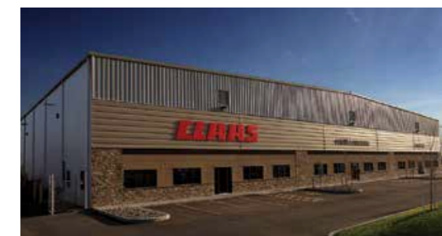
Le Centre logistique de pièces détachées CLAAS de Regina, dans le Saskatchewan, entrepose plus de 14 000 références de pièces dans un entrepôt de plus de 1 580 m 2 .
