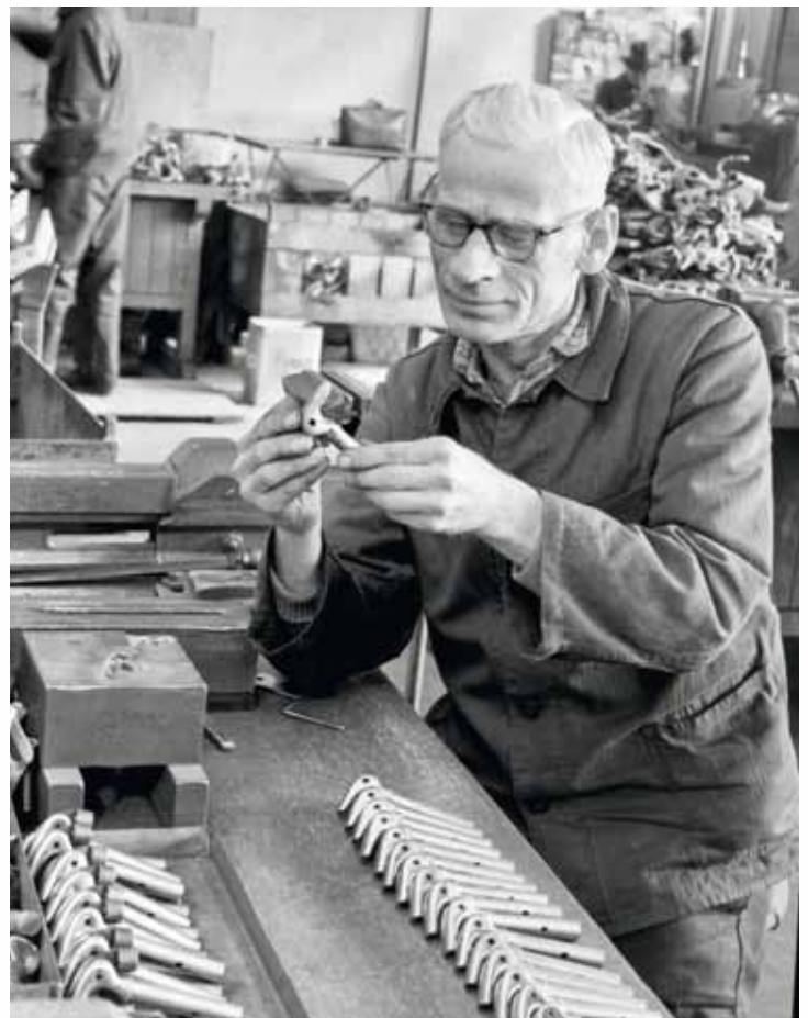
Qualität erforderte viel Handarbeit und Präzision. Georg Szyszka kontrolliert die Knoter für Strohpresen – ein Bild aus dem Jahre 1962.
