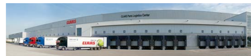
Das CLAAS Parts Logistics Center in Hamm, Deutschland, verfügt über 155.000 verschiedene Teile auf mehr als 100.000 m 2 Betriebsfläche.
